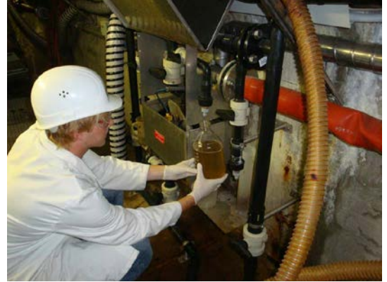
Abb. 2: Probenahme für die Analyse von Schmutzwasser in Kammer am Fuss der SMDT.
