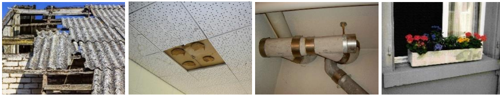
Exemples d'amiante fortement lié: Eternit ou plaques de fibrociment, plaques de plafond, tuyaux en amiante-ciment, bacs à fleurs.
